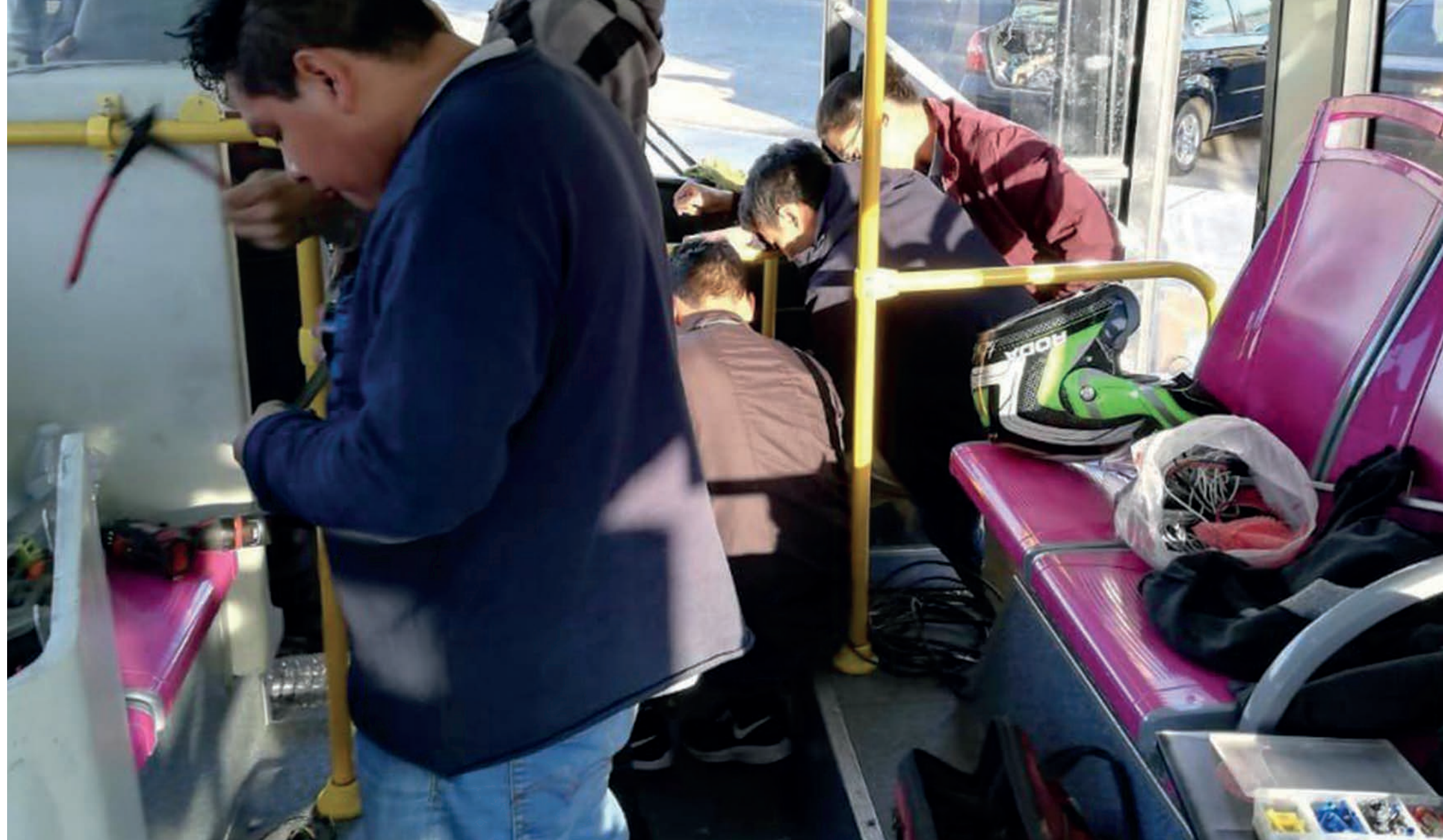
Instalación de equipos del Proyecto de Monitoreo Integral y Seguridad del Transporte Público vía GPS de la Ciudad de México, fuente: Órgano Regulador de Transporte 2019.
